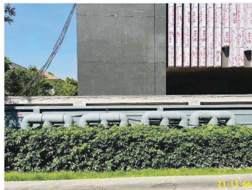
ปอดินกำจัดมีเทน (Methane) และท่อกำจัด Aerosol
